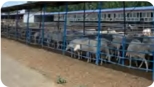
沙雅县农村产业融合建设项目
