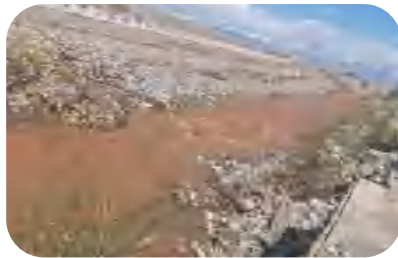
温宿县台兰河灌区水利枢纽工程
