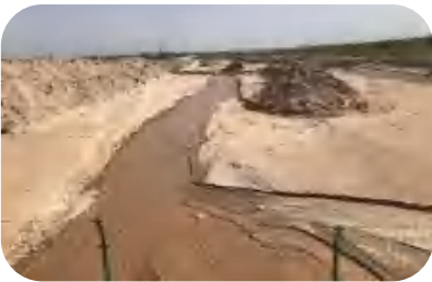
阿瓦提县丰收灌区灌溉支渠
